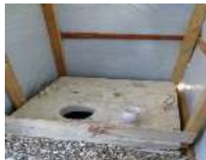
prov. Toilette- Arborloo
