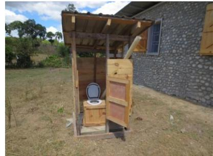
Das Klo kann bei Bedarf einfach umgesetzt werden. Die bisherige Grube wird einfach zugeschüttet und die Stelle anschließend bepflanzt, die Düngung erfolgt dann von unten.
