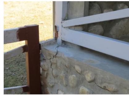
Zwischenzeitlich gilt es bereits, den einen oder anderen Fehler zu beheben. Beide Häuser sind mit an einigen Stellen mit Stahlträgern verbunden. Da der Boden hier stark arbeitet - insbesondere nach der Regenzeit - müssen wir die Verbindungen lösen, da es sonst zu Gebäudebeschädigungen (Rissen) kommt, wie man sieht.
